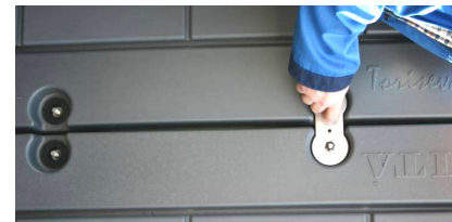
Kiinnikkeitten asennus, kansi
